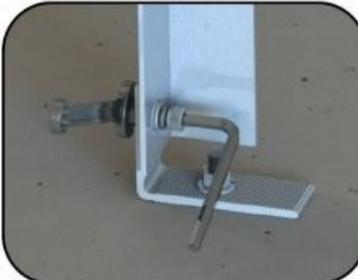
Fixar os Catetos da estrutura, nos SUP 961 fixados ao solo, com auxílio de uma chave de boca 13mm e uma chave allen 6mm. Conforme figura abaixo:
