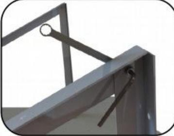
Fixar as Hipotenusas da estrutura, nos SUP 961 fixados ao solo, e nos catetos fixados anteriormente, com auxílio de uma chave de boca 13mm e uma chave allen 6mm. Conforme figura abaixo:
