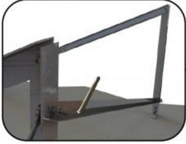
Fixar o Contravento da estrutura, nos catetos fixados ao solo, com auxílio de uma chave de boca 13mm e uma chave allen 6mm. Conforme figura abaixo:
